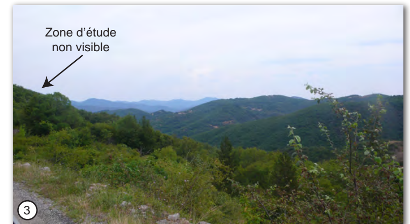
Depuis la RD 48, la présence du puech situé entre Montardier et la zone d'étude (altitude de 666 m NGF), empêche les relations visuelles avec les terrains de la zone d'étude. Seule les zones les plus à l'Est et sur les pentes sont visibles en quelques points de vue sur cette route (au niveau du Mas de Court par exemple).
